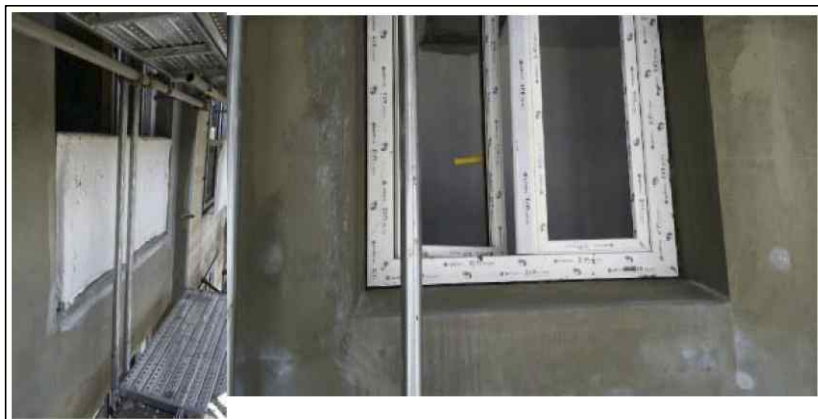
<일반 벽면 및 창호부위 메쉬 미장 후>
