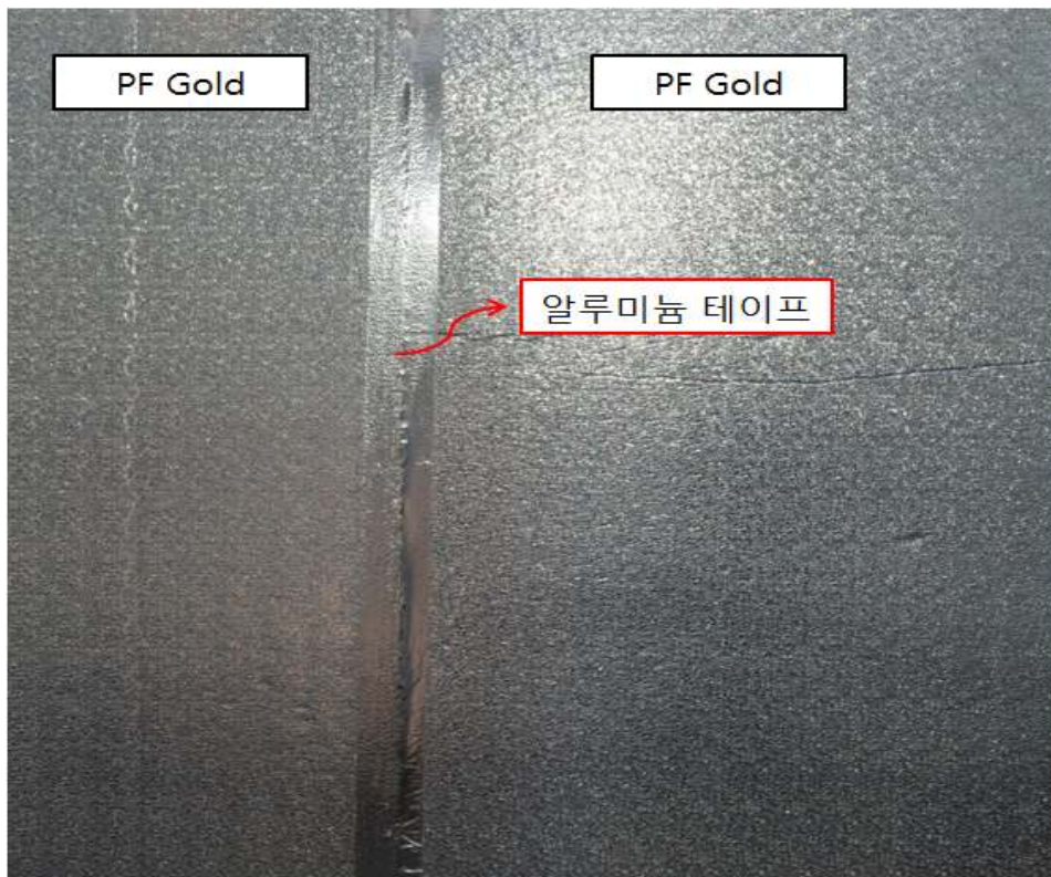
<PF Gold와 PF Gold의 접하는 부위 알루미늄 테이프 부착 모습>
